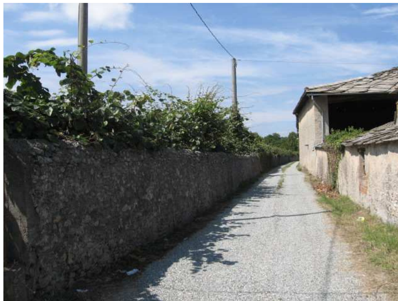
La viabilità rurale storica del versante collinare
