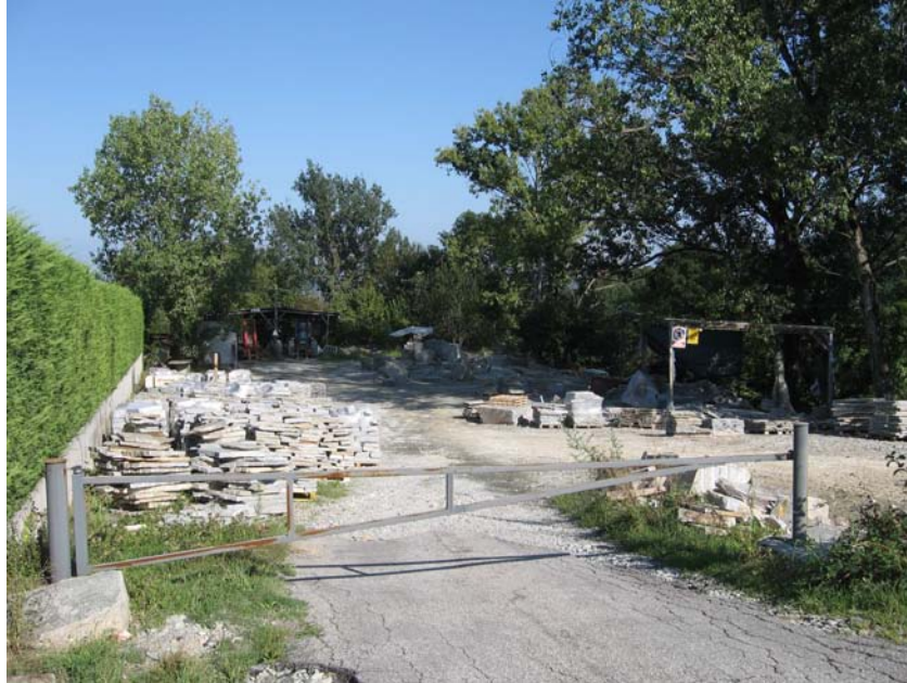
Area C27 vista da Via Bagnolo
