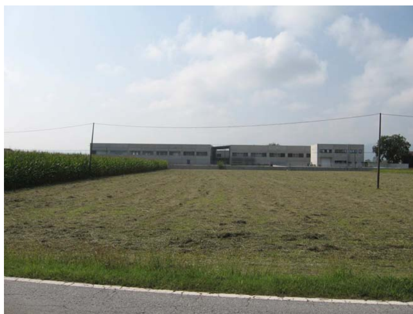
L'area C 19 vista da via Cardè
